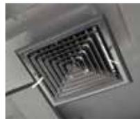
L'extracteur d'air et la VMC simple flux créent une dépression et nécessitent donc de pouvoir aspirer de l'air extérieur à un autre endroit dans la pièce / le bâtiment.
